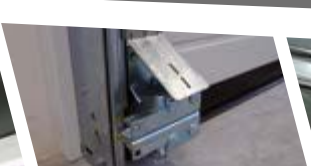
Paracadute cavi Cable break safety device Seilbruchsicherungsrichtung
