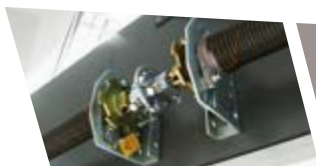
Paracadute molle Spring break safety device Federbruchsicherungsrichtung
